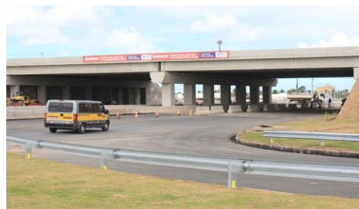
Figura 5 - Novos trechos do viaduto do Geisel.
